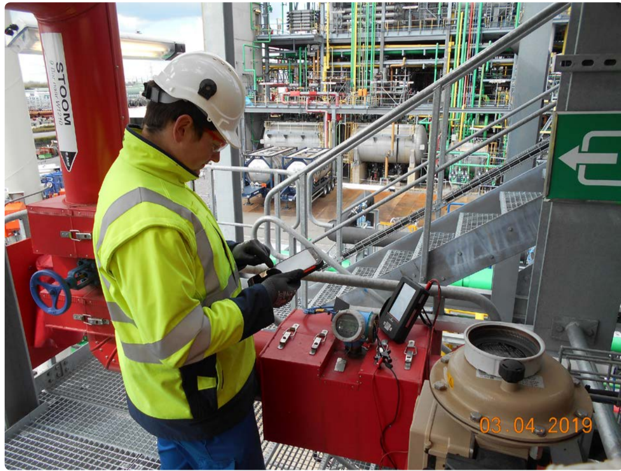
Loop-Checks im Blick: Mit digitaler Anlagendokumentation hat der Projektleiter jederzeit den Überblick über den aktuellen Stand der Tests.
