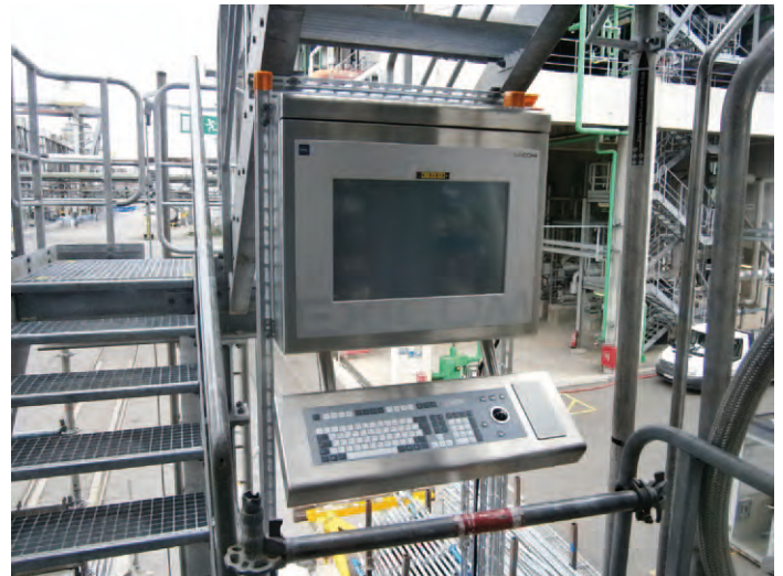
Bild 3: Seit Mitte 2014 ist die neue Tankabfüllung in Betrieb. Die Mitarbeiter werden elektronisch durch die Arbeitsprozesse geleitet; alle relevanten Informationen sind auf einen Blick verfügbar. Dadurch werden (teure) Fehler vermieden; außerdem ist jederzeit dokumentiert, wer welchen Arbeitsschritt wann und wo ausgeführt hat. (Foto: BASF)
