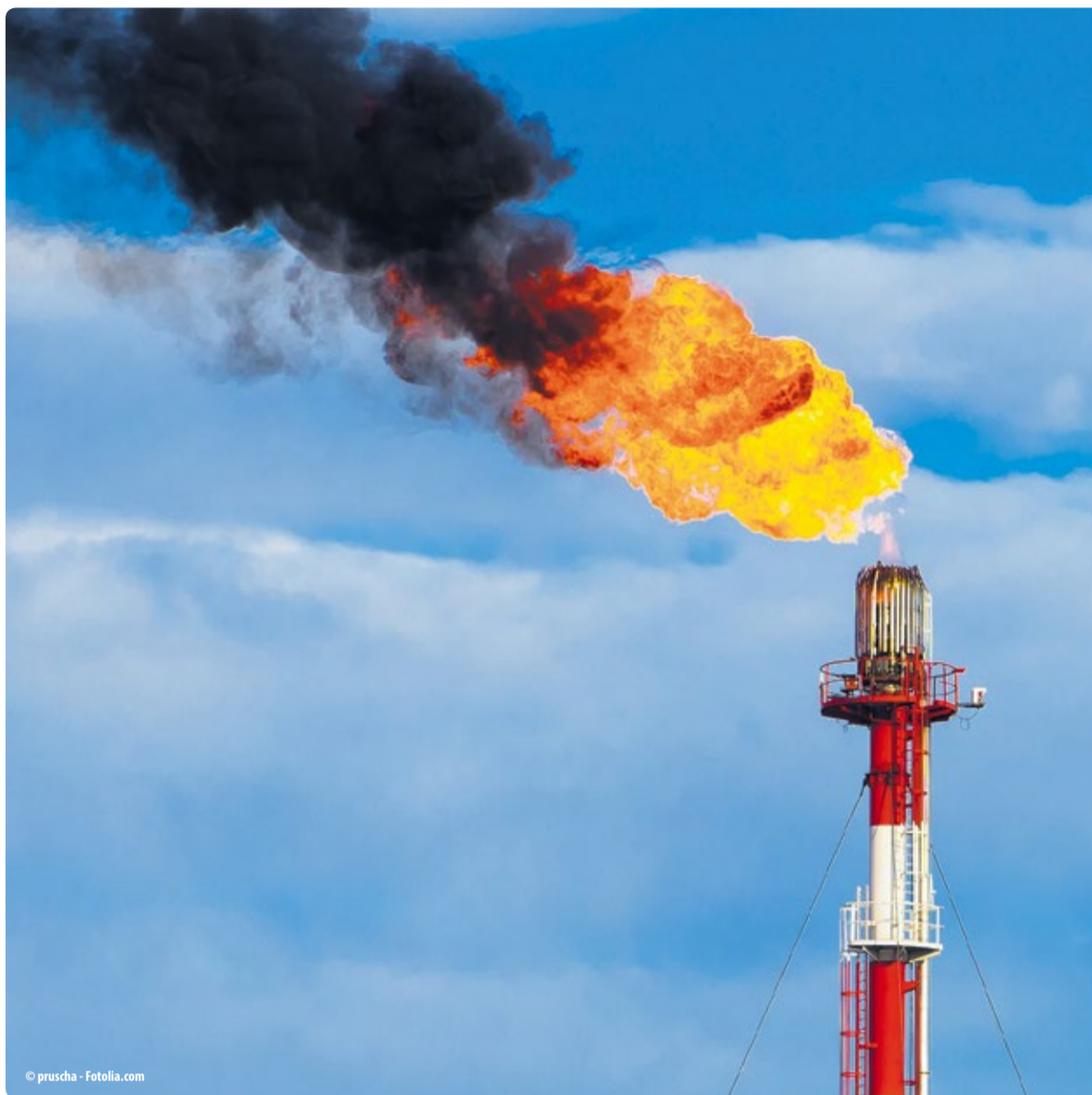
Zum Schutz von Mensch und Umwelt sollen Abfallgase in Fackeln möglichst rußfrei und mit hohem Ausbrenngrad verbrannt werden
